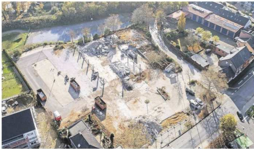
Dieses Areal, auf dem ein Discounter abgerissen wurde, soll für Gebäude mit Wohnungen und Gewerbe genutzt werden.
